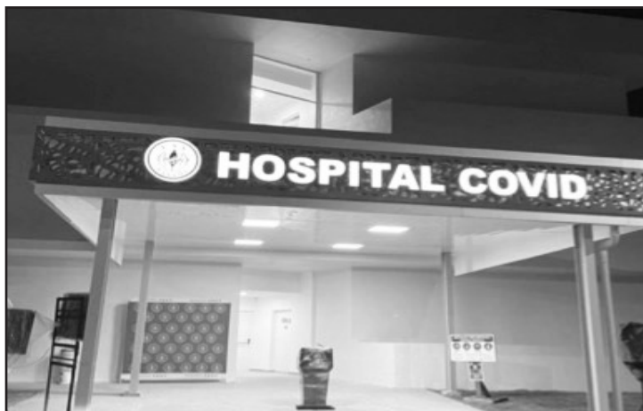
Un “hospital” dentro de un hospital en construcción.
